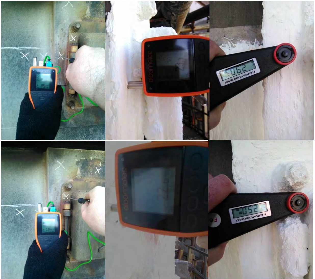
Рисунок 1. Замер температуры неизолированной и изолированной поверхностей, а также толщины нанесенной изоляции в точках контроля №3 и №6 16.03.16.
