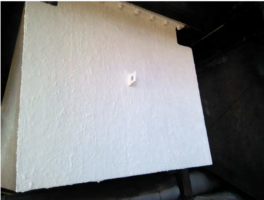
Рисунок 2. Изолированный участок площадью 1,6 \text{ м}^2 на высоте обслуживания +16240
