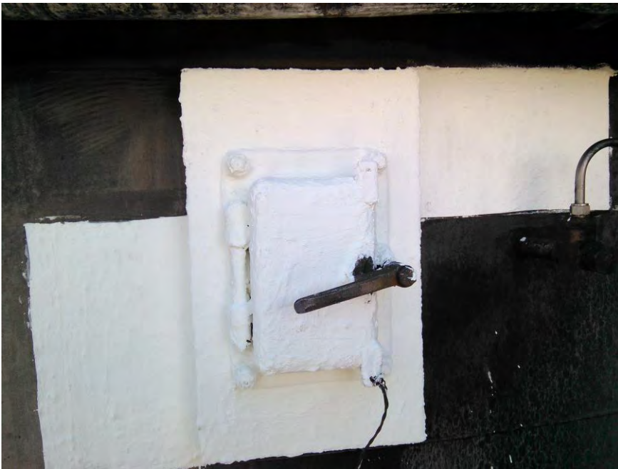
Рисунок 3. Изолированный участок на отметке +12360 площадью 0,6 \text{ м}^2
