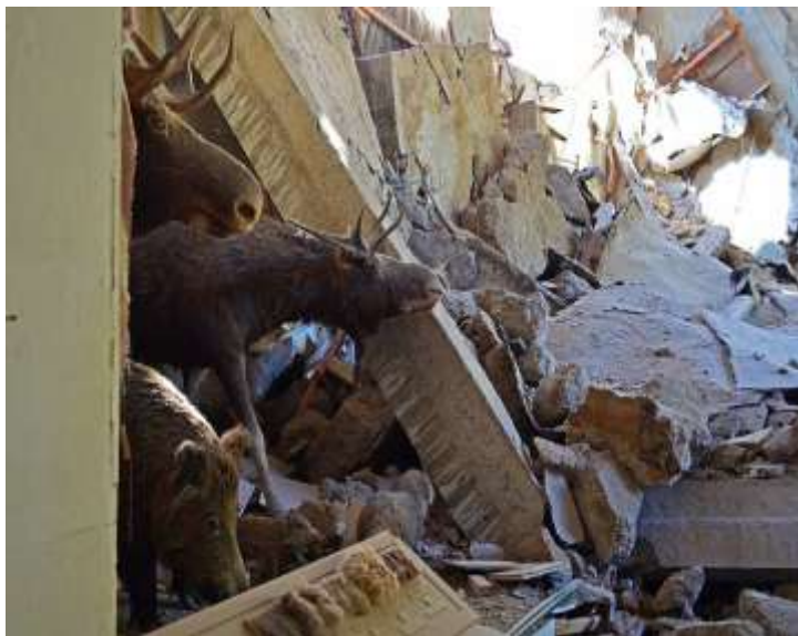
Разрушения в Краеведческом музее. Фото Всеволода Петровского
